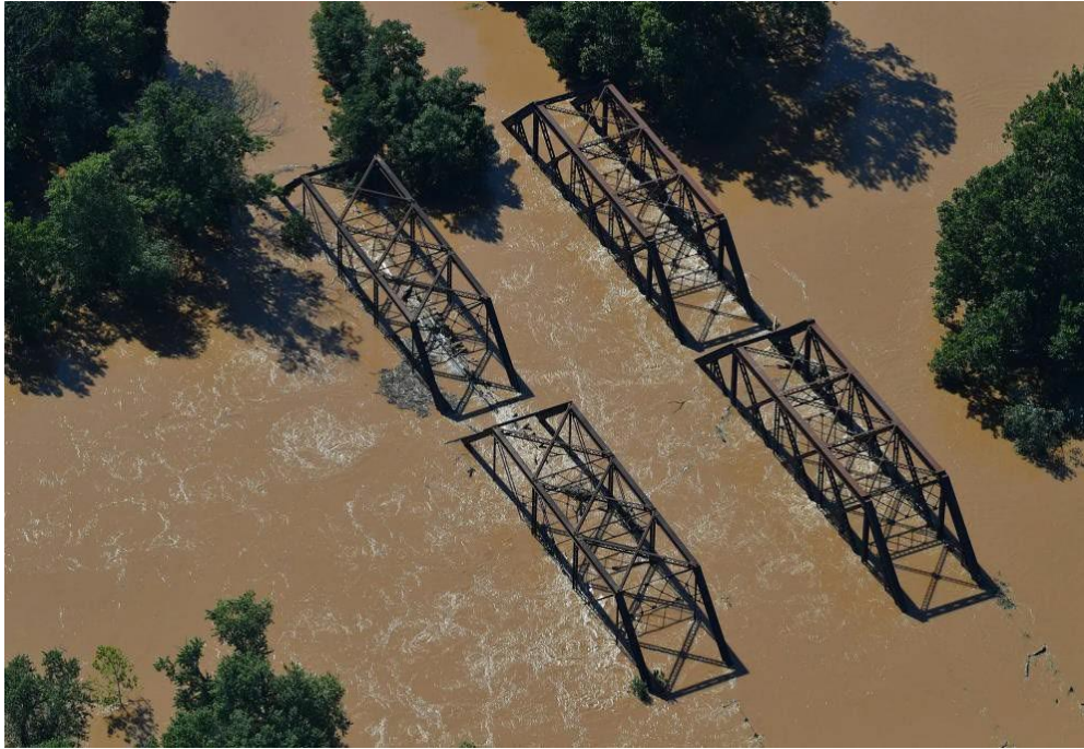
Fig. 15: Puente Inundado por las crecidas de agua en el condado de Somerset
